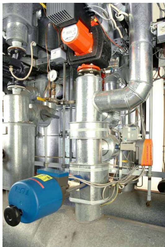
Рис. 14: Главный распределитель с BOA-Systronic
