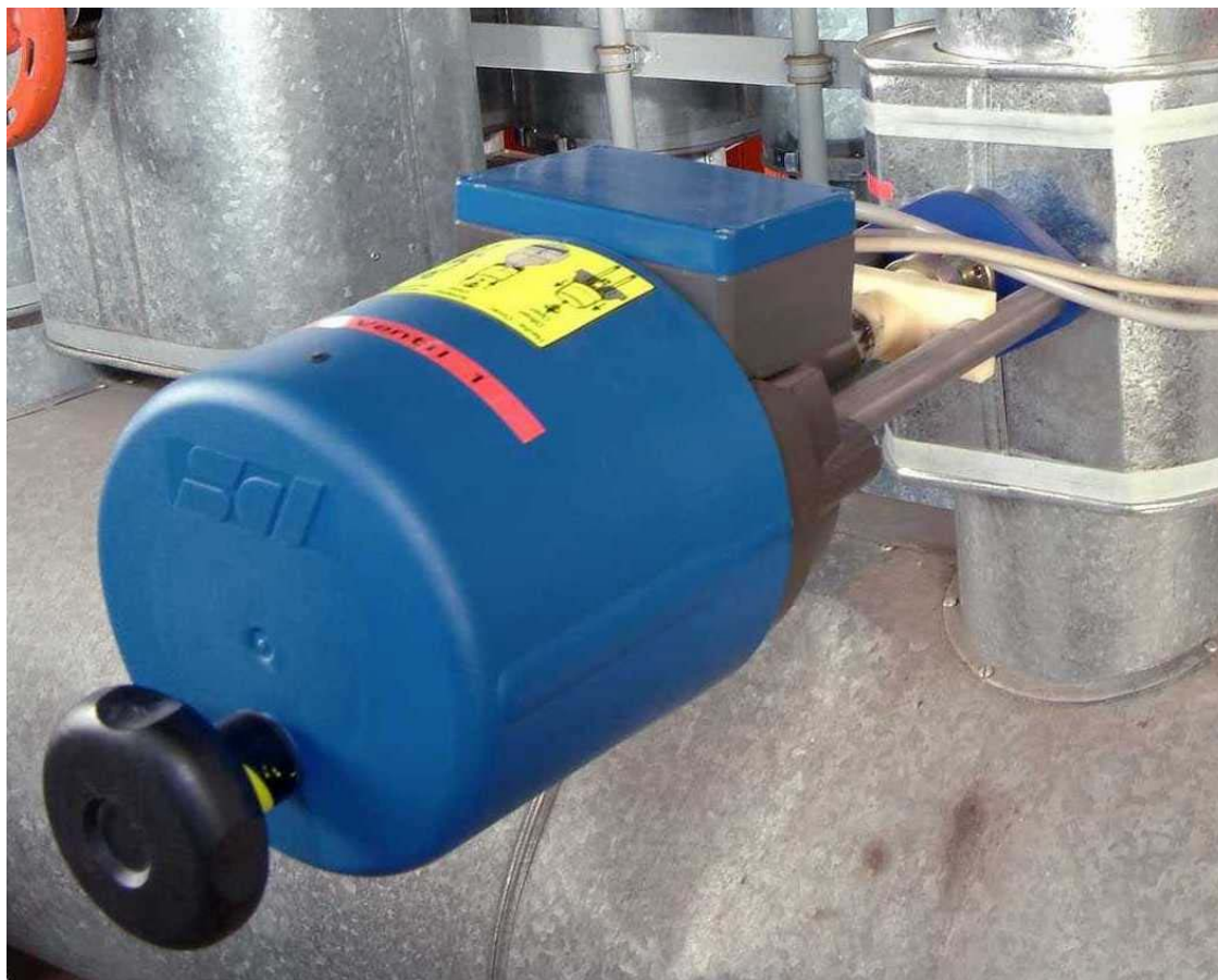
Рис. 15: Главный регулирующий вентиль BOA-Systronic
