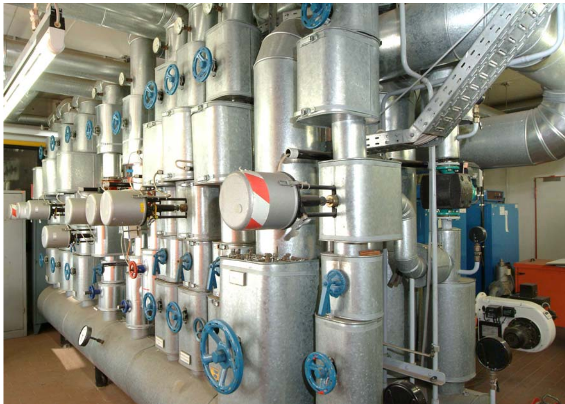
Рис. 10: Коллектор «обратной» воды
