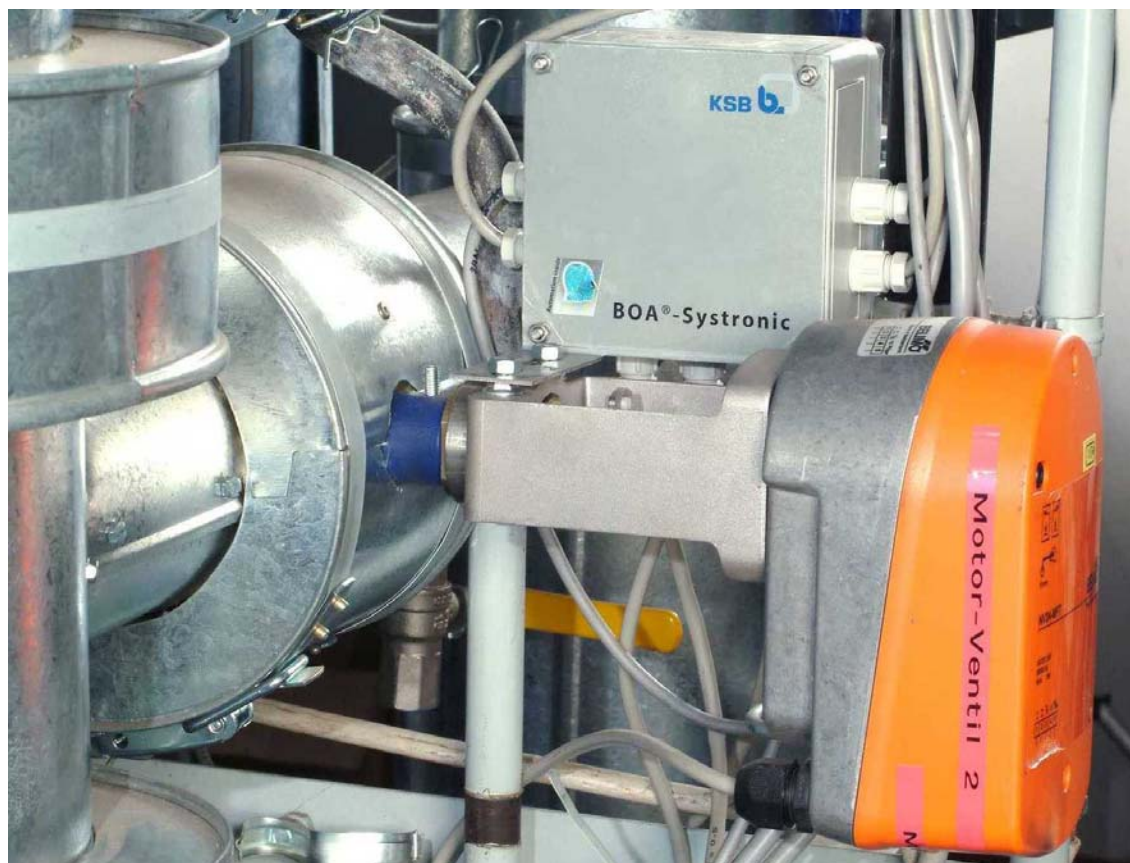
Рис.16: Трехходовой вентиль BOA-Systronic
