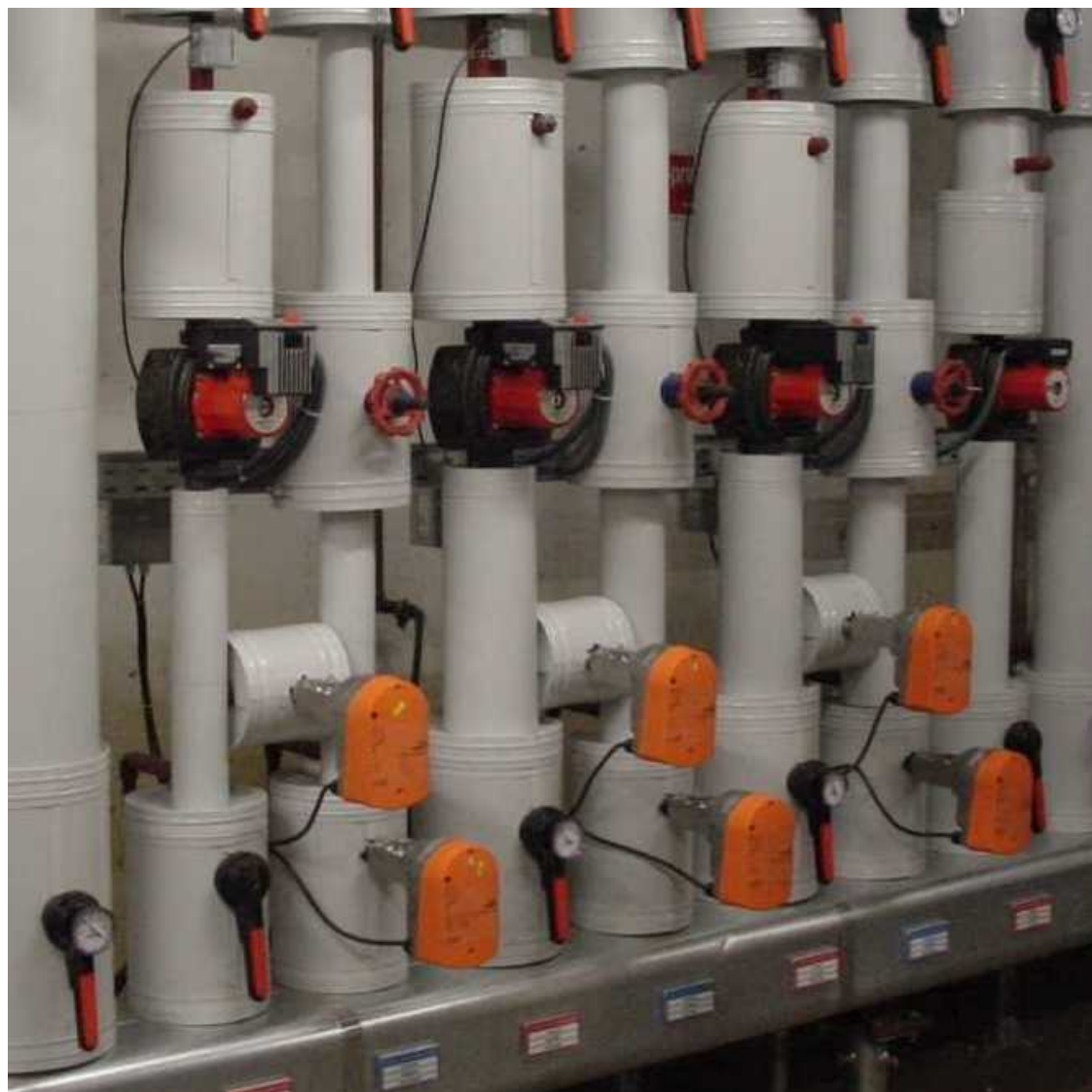
Рис. 23: Главный распределитель с BOA-Systronic DN32
